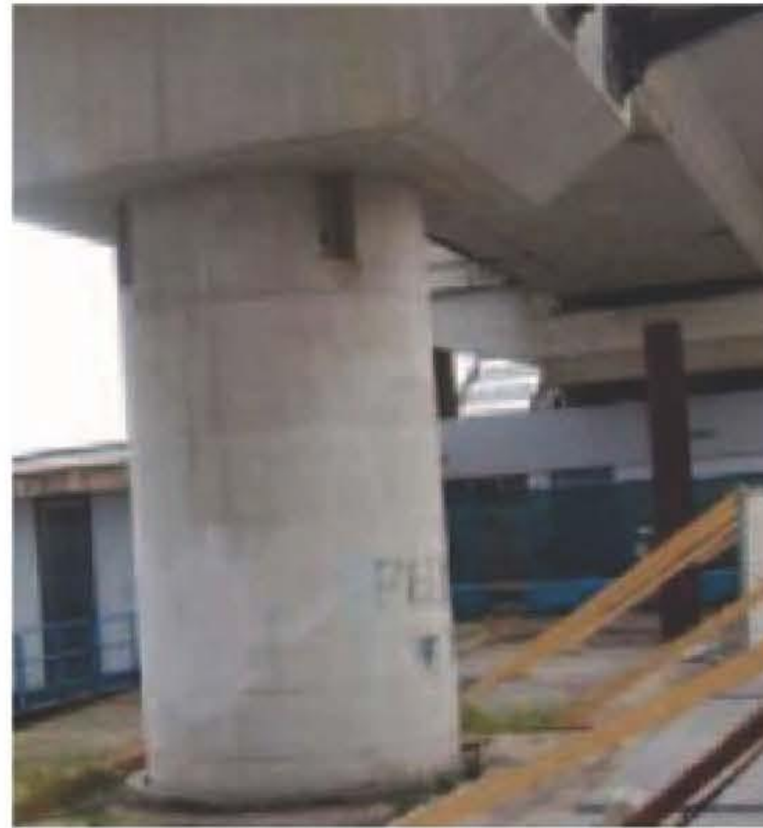
● Il cantiere a Scampia ■ primo piano alle pagine 2 e 3
