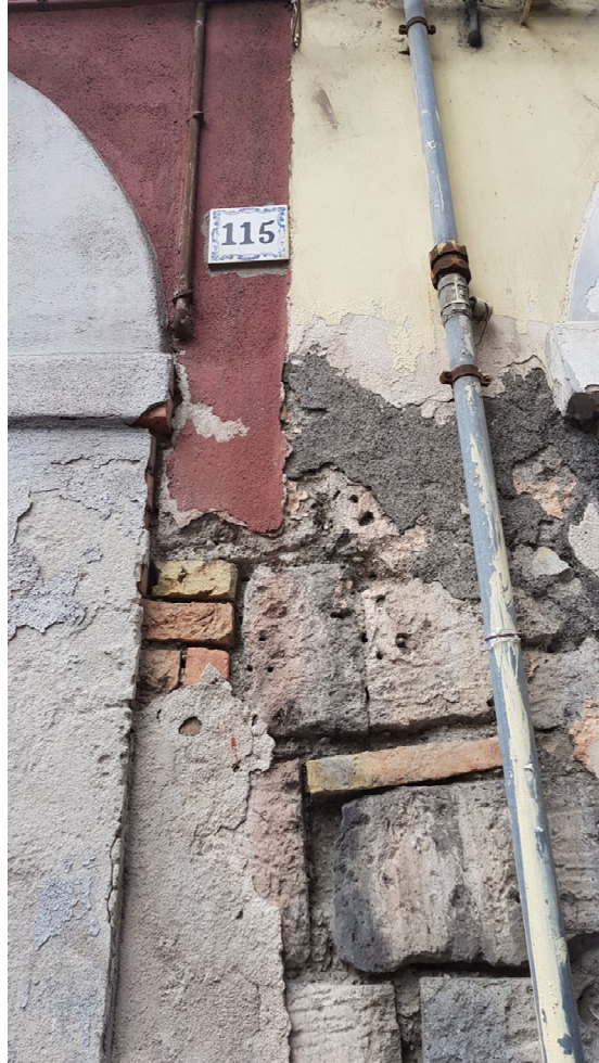
Edificio in muratura
