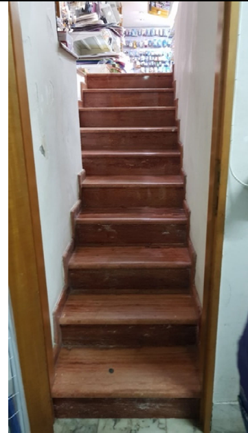
Scala di accesso al piano interrato
