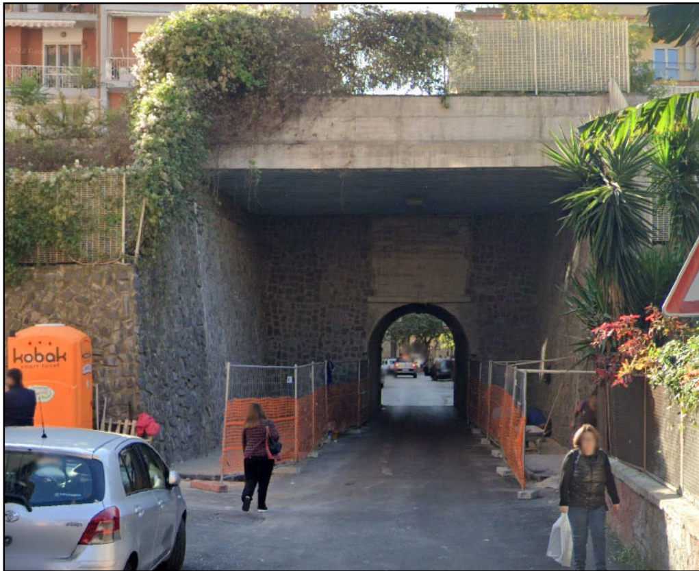
Figura 3.6 – Sottopasso stradale/ferroviario via de Nicola
