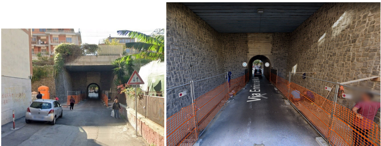
Figg. 17-18 Viste del tratto del ponte De Nicola già adeguato dal Concessionario.
