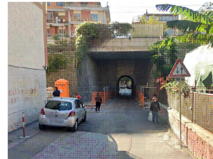
VISTA LATO LINEA FERROVIARIA
