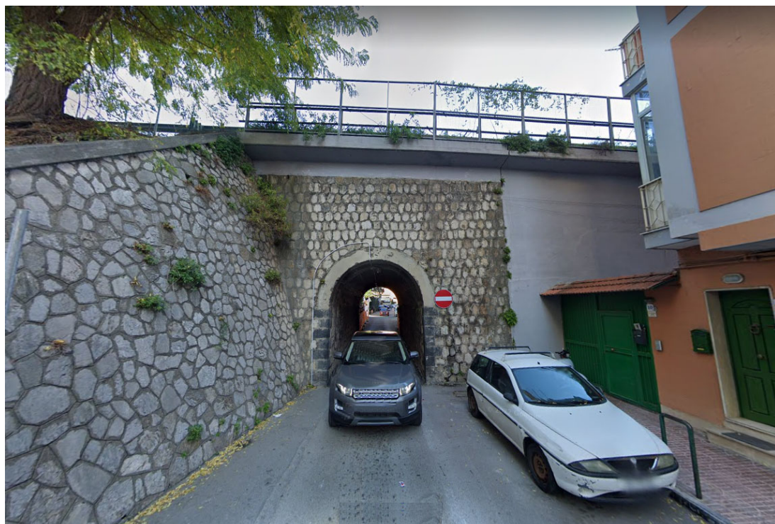
Figura 17: Ponte De Nicola – tratto su cui insiste linea Circumvesuviana
