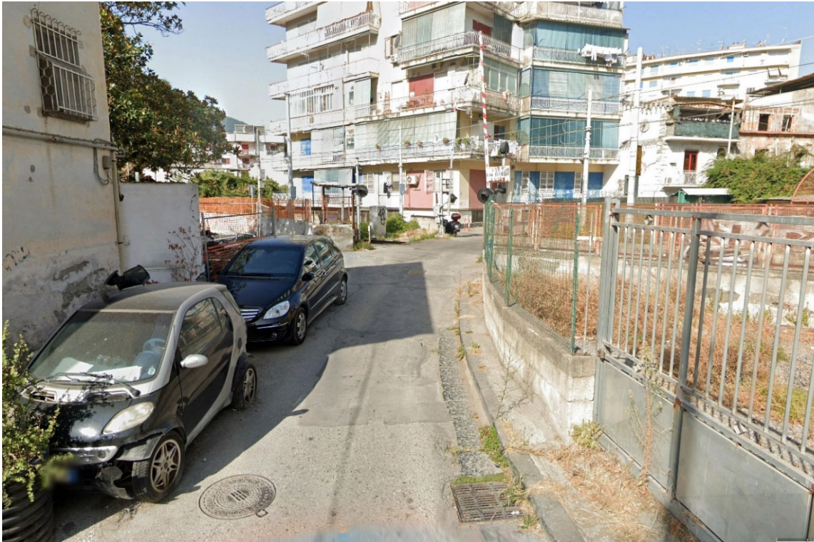
Figura 3 : Passaggio a Livello su Via Grotta San Biagio
