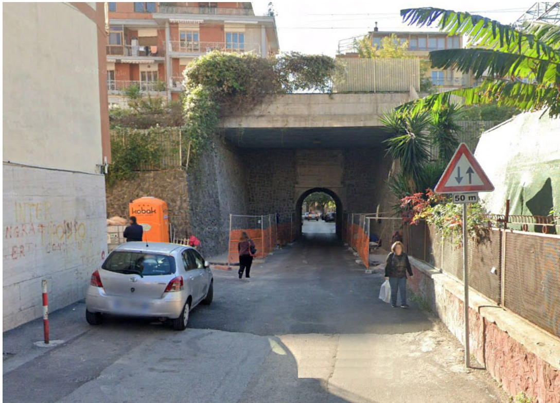
Figura 16: Ponte De Nicola – tratto su cui insiste Corso Italia
