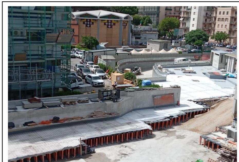
1 Realizzazione caldana lungo i camminamenti in uscita dalla scala A dell'autorimessa
