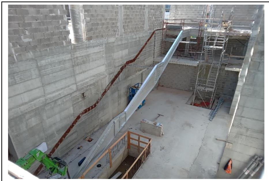
1 Montaggio cosciale scala in acciaio corpo stazione lato ovest
