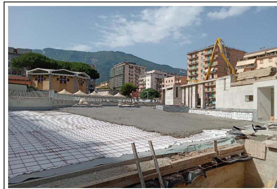
2 Dettaglio caldana lungo i camminamenti in uscita dalla scala A dell'autorimessa
