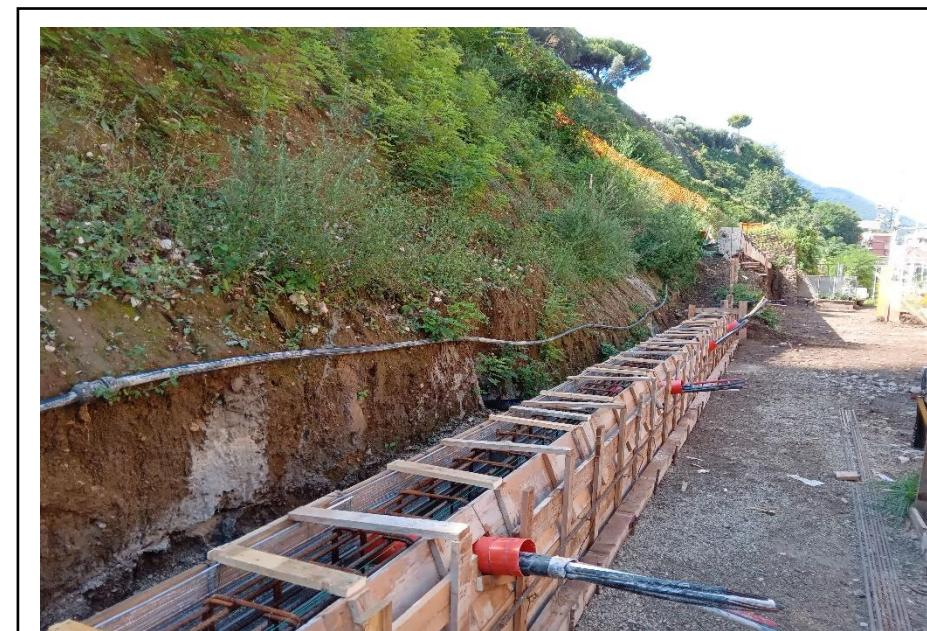
4 Montaggio carpenteria cordolo sezione 47-44
