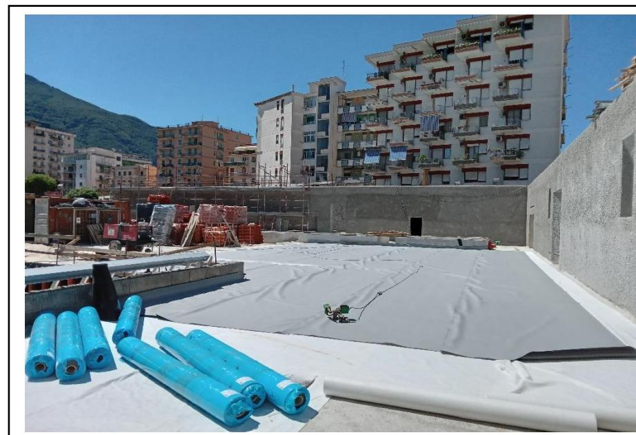
4 Impermeabilizzazione massetto delle pendenze
