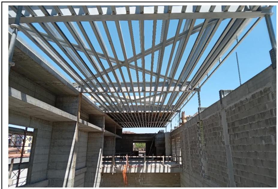
1 Montaggio copertura in lamiera corpo stazione lato ovest
