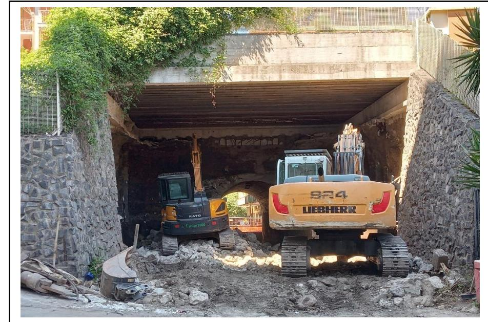
2 Demolizione spalle ponte Via De Nicola per allargamento carreggiata
