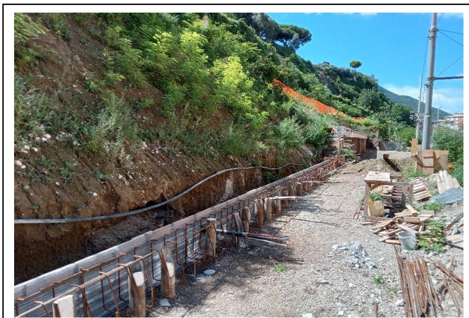
3 Montaggio armatura cordolo sezione 47-44
